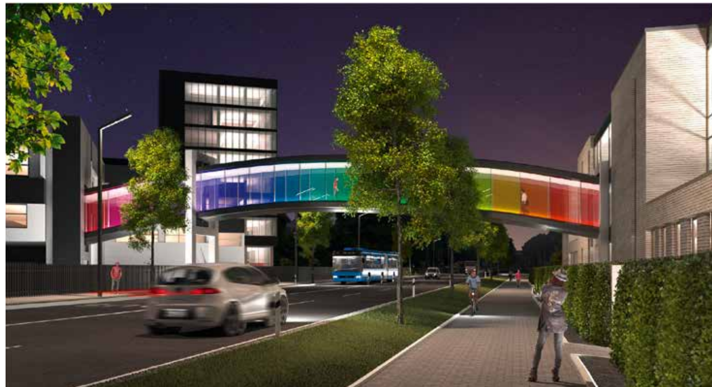
Die verglaste und leicht gebogene Verbindungsbrücke überzeugt durch Schlichtheit und verbindet das Brillux Unternehmensgebäude (links) mit dem Gästehaus B-Wohnen (rechts).
