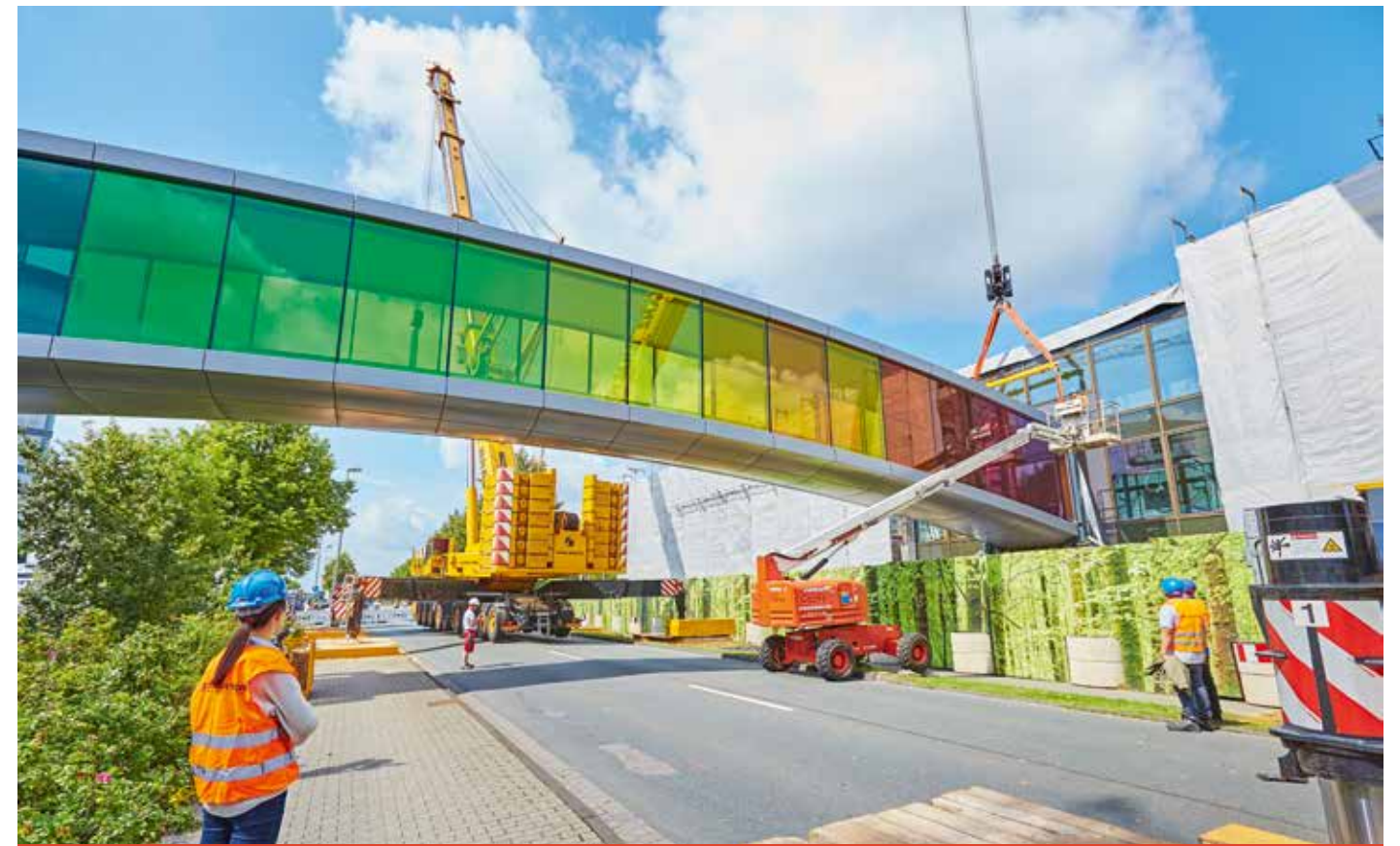
Einhub der Brücke am 21. Juli 2019
