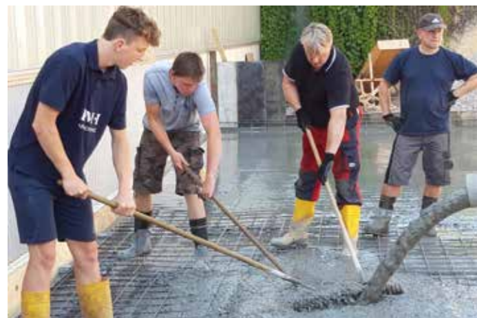
Betondecke gießen
